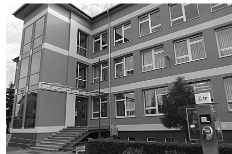
Wykonawcą robót był Zakład Usług Ogólnobudowlanych Mirosław Miałkowski z Kłody
