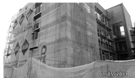
Wykonanie zadania budynku Urzędu Miejskiego w Sławie wykonuje Zakład Remontowo-Budowlany „BLACH-DEK” Tadeusz Piskorz z Wolsztyna
