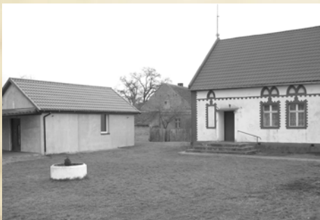
Świetlica wiejska w Goli
