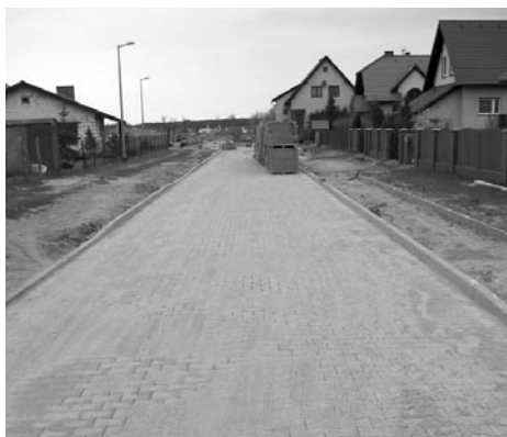
Intensywne prace przy ul. Złota Podkowa
